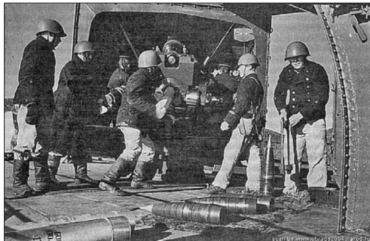
Раздельное заряжание установки Б-13. На переднем плане видны снаряды и гильзы с зарядами. Фото из свободных источников.
