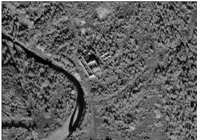
Остатки зданий Эльгенской паротурбинной электростанции на спутниковом снимке.
