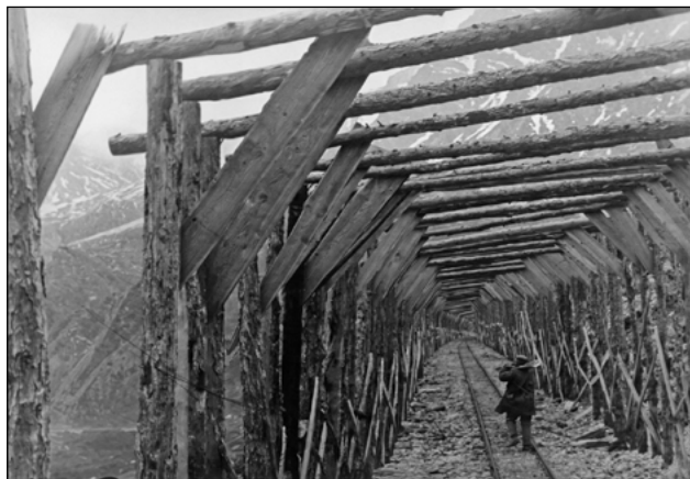
Защитная галерея против снежных заносов. Узкоколейная железная дорога рудника «Бутугычаг». 1942–1945 годы. Фото из архивов МОКМ.
