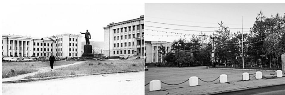
У «Северовостокзолото». Здание Главного и Политического Управлений (затем СВЗ) принято госкомиссией в апреле 1941 года; второе административное здание сдано в 1953 либо 1954 году
