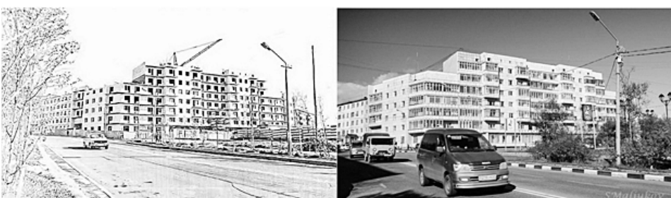
Строительство дома «Восточной медицины»
