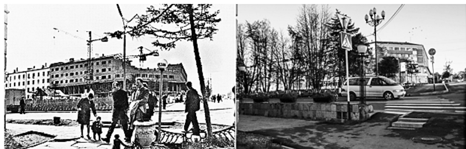
Строительство дома, где будет магазин «Восход», в 1964 году Дом начал заселяться в 1965 году, универмаг «Восход» открылся в начале 1966 года.
