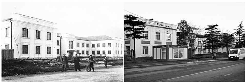
В 40-х годах прошлого века в этом здании располагался Магаданский погранотряд. С мая 1948 года здание было передано Магаданскому политехникуму. Здание построено в 1936 году. Одно из первых зданий города, построенное из кирпича и существующее по сей день
