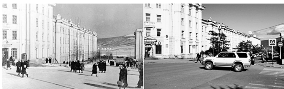
Перекресток улицы Пролетарской и проспекта Ленина. Телеграф вступил в эксплуатацию в октябре 1935 года
